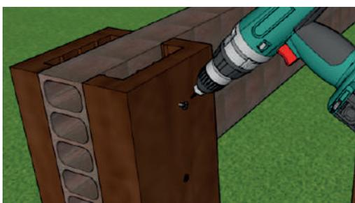
Feito o encaixe, são inseridas as vigas e fixadas com dois parafusos grandes 4,8 x 70 inox pelo pilar, chegando até as vigas inferiores, fazendo o travamento.
